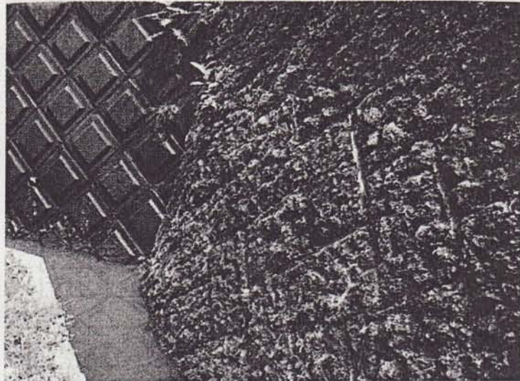
従来のコンクリートブロック(左)と、施工後4年で植物が根付いたというナチュロック
