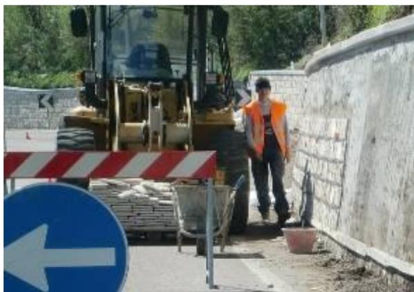
コンクリート面に薄い石を貼っている工事
