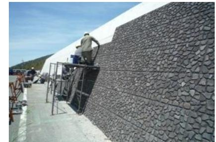
コンクリート面に溶岩パネルを貼る
