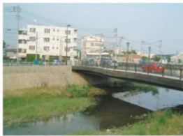
河川施工例 玉石
