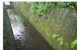
河川施工例 甲州
