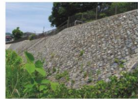
河川施工例 石張り
