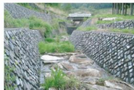
河川施工例 甲州
