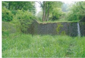
砂防施工例 甲州
