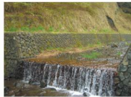
砂防施工例 甲州
