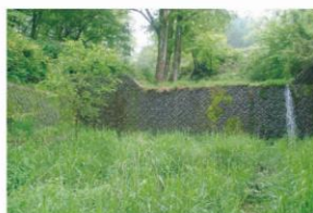
砂防施工例 甲州
