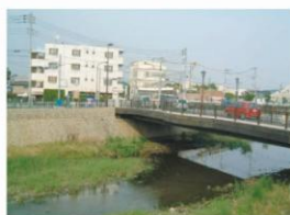
河川施工例 玉石
