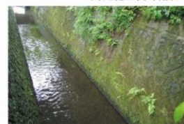
河川施工例 甲州
