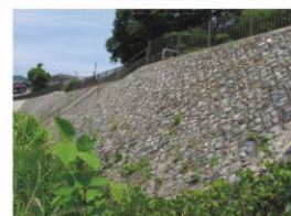
河川施工例 石張り
