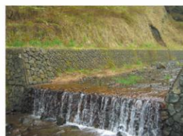
砂防施工例 甲州
