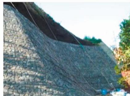
施工例 神奈川県
