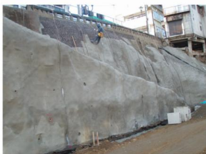
モルタル吹付法面
