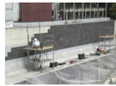
大きな重機を使わない
