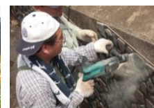
市民参加による施工
