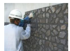
パネル取付け
