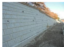
積みブロック擁壁
