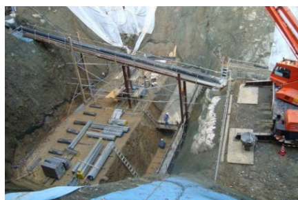
1. 砂防工事現場
