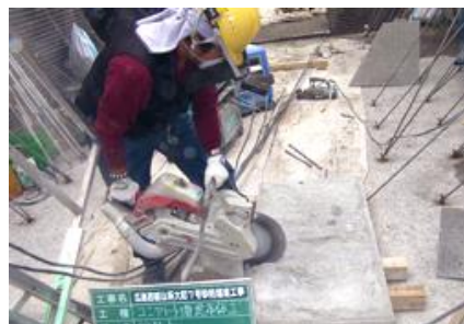
5. 型枠パネル切断加工状況
