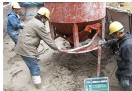
6. コンクリート打設状況
