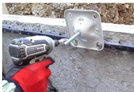
4. 専用組立部材取付状況
